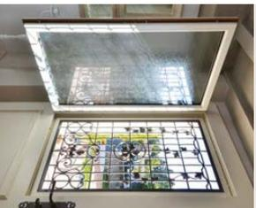
Le châssis ouvrant permet l'aération de la maison, l'identification de vos visiteurs, l'entretien de la grille et le nettoyage du vitrage.
