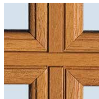
Petits bois assemblés à parclose extérieure (vue extérieure)
